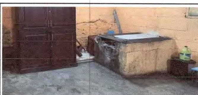
Foto 6: Sustitución de piso de cemento liquido.
