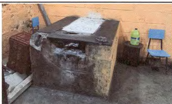
Foto 17: Sustrucción de estufa rural (completa) incluye chimenea y plancha de metal. Instalación de azulejo en estufa rural.
