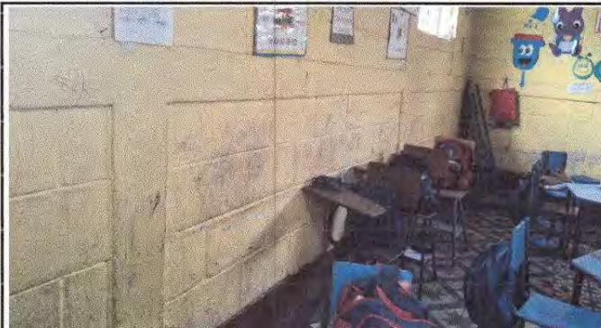
Foto 8: Pintura en muros interiores.
