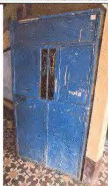
Foto1: Mantenimiento a estructura (lijado, cambio de tubo, cepillado, sujecioens, aplicacián de pintura).
