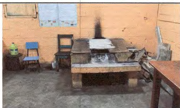
Foto 16: Sustrucción de estufa rural (completa) incluye chimenea y plancha de metal. Instalación de azulejo en estufa rural.
