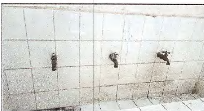
Foto 12: Sustitución de llave de chorro.
