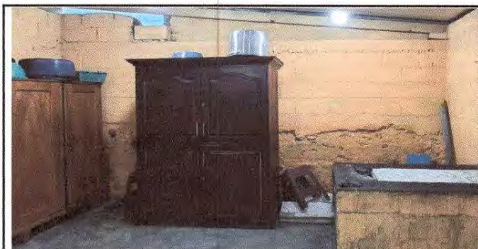
Foto 18: Repello en muro.
