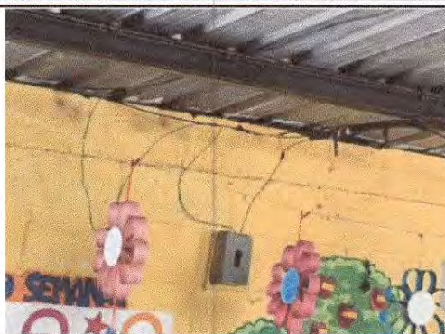
Foto 14: Sustrucción de tablero de flipones.
