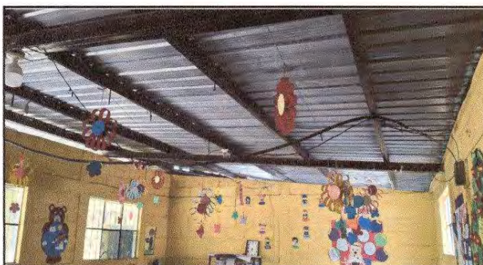
Foto 15: Reparación de cableado eléctrico
