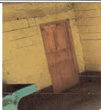
Foto 2: Sustitución de puerta.
