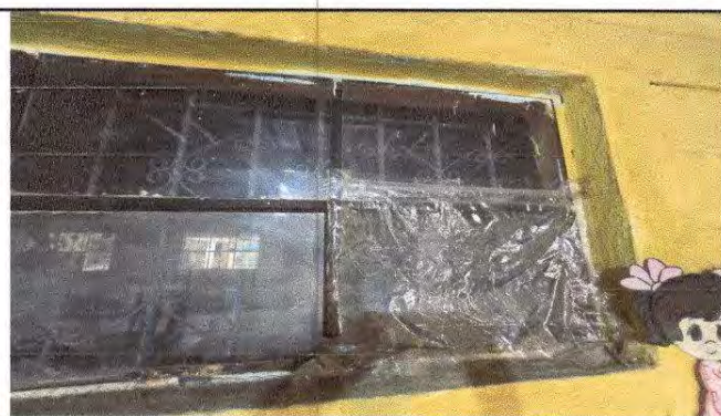
Foto 4: Sustitución de vidrios.
